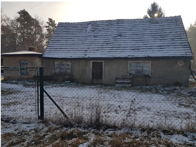
Die Adamschenke am 07.12.2021. Der Anbau links stammt aus den 1950er Jahren. Das Gebäude war bis 1985 bewohnt.
