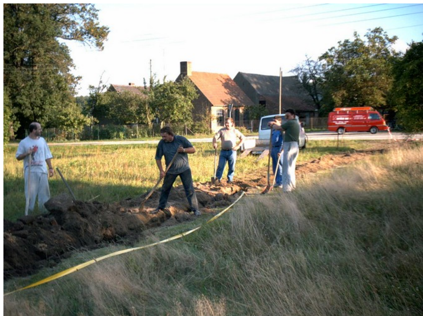
Die Kameraden beim Herstellen der Stromversorgung des Platzes
